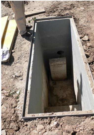
LE DESSABLEUR : Il est opérationnel. Il permet de préserver la station d'épuration par le maintien de l'excès de sable .
